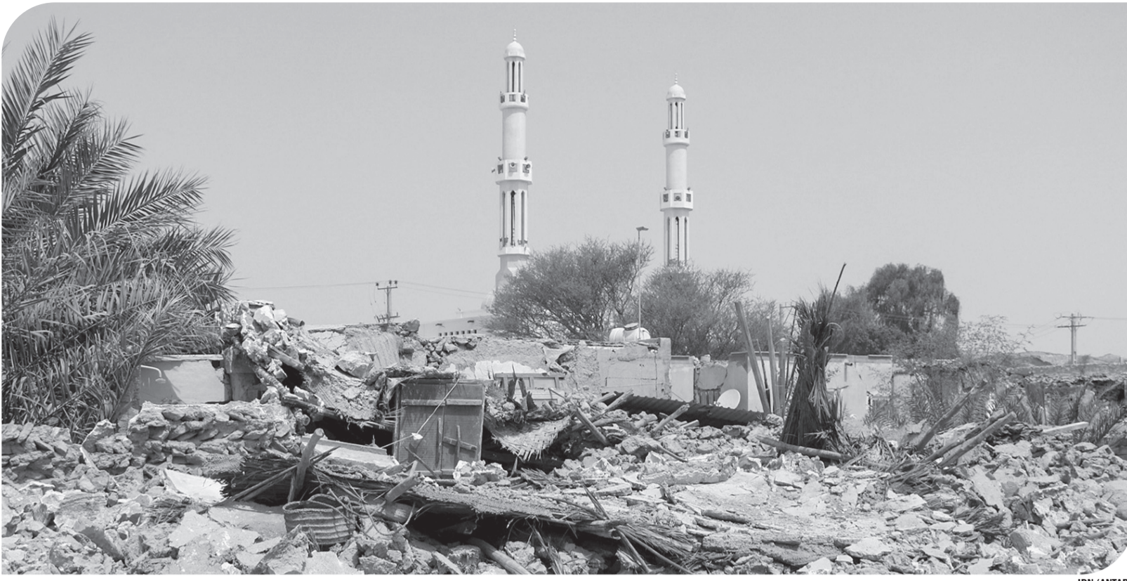
KONDISI PASCA GEMPA DI HORMOZGAN - IRAN
